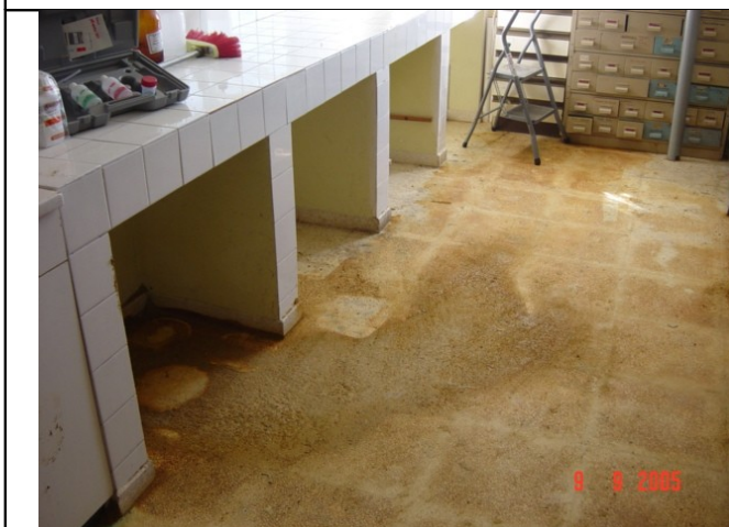
Estat final del terra del laboratori després de la neteja
