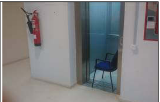
L'equip d'intervenció ha bloquejat els ascensors
