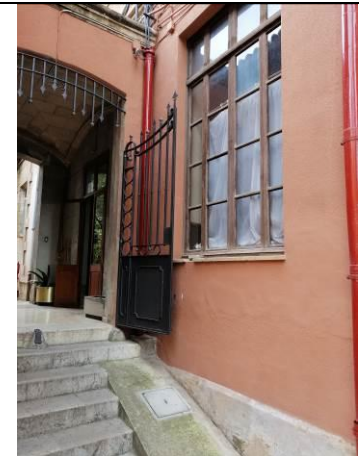
La gent arriba per l'escala interior a la planta baixa, però la sortida està tancada amb clau, i és impracticable per l'acumulació de mobles. La normativa no permet evacuar a través d'un local de risc (bar). S'ha d'obrir porta d'accés directe, per la finestra.
