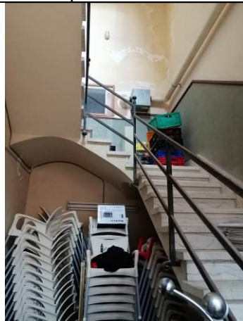
La gent arriba per l'escala interior a la planta baixa, però la sortida està tancada amb clau, i és impracticable per l'acumulació de mobles. La normativa no permet evacuar a través d'un local de risc (bar). S'ha d'obrir porta d'accés directe, per la finestra.
